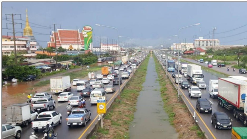
รูปที่ 4 สภาพการจราจรติดขัดบนถนนพระราม 2 (ทางหลวงหมายเลข 35)
