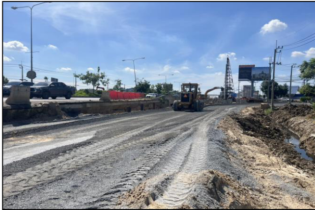
รูปที่ 7 แสดงรูปงานก่อสร้างทางเบี่ยงการจราจรชั่วคราว
