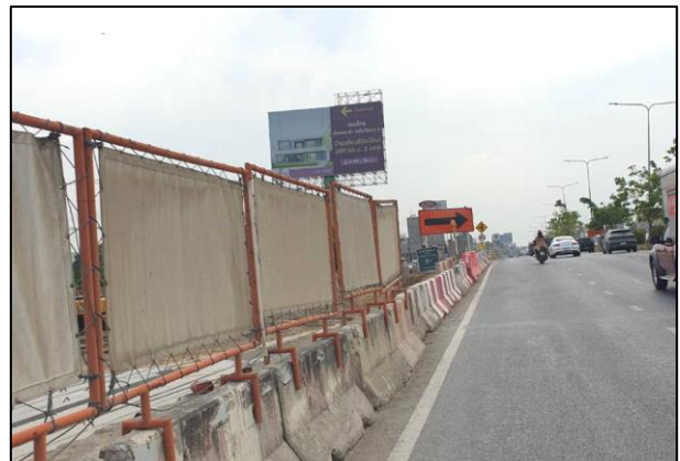
รูปที่ 9 แสดงรูปการติดตั้งอุปกรณ์อำนวยความสะดวกภัย ป้ายจราจร ระบบไฟฟ้าส่องสว่าง บนทางเบี่ยงการจราจรชั่วคราว
