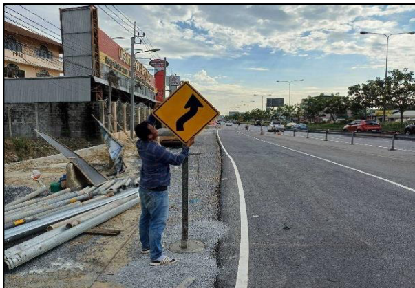
รูปที่ 9 แสดงรูปการติดตั้งอุปกรณ์อำนวยความสะดวกภัย ป้ายจราจร ระบบไฟฟ้าส่องสว่าง บนทางเบี่ยงการจราจรชั่วคราว
