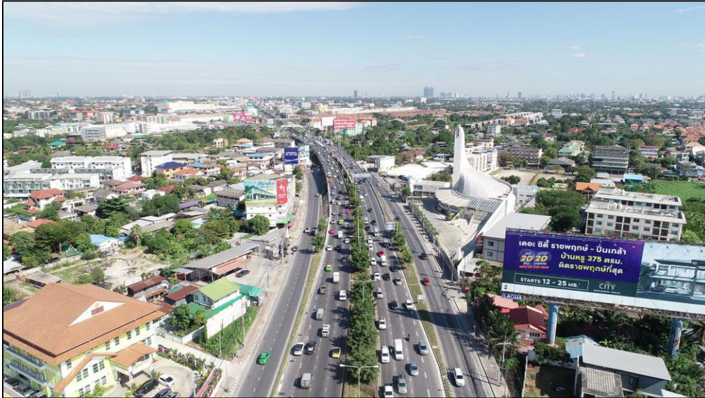
รูปที่ 2 ทศนิยมภาพก่อนมีโครงการ มี 3 ช่องจราจร/ทิศทาง และบริเวณสะพานข้ามคลองมหาสวัสดิ์มีสภาพเป็นคอคบด
