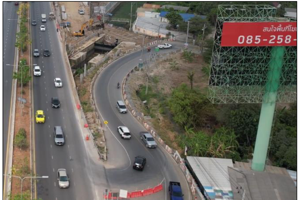
รูปที่ 11 แสดงรูปทางเบี่ยงการจราจรชั่วคราว (หลังเปิดการจราจร)
